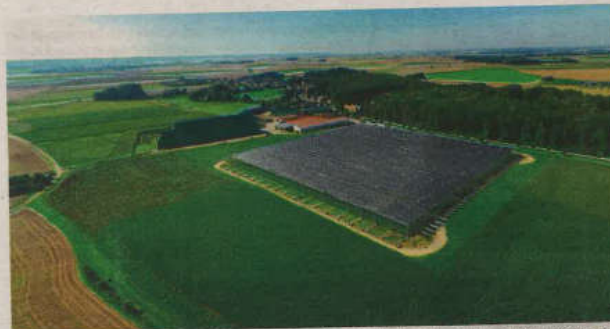
« L'installation est probablement un système de protection contre les aléas climatiques, que sont la grêle, le gel tardif, la sécheresse et les fortes températures. »
