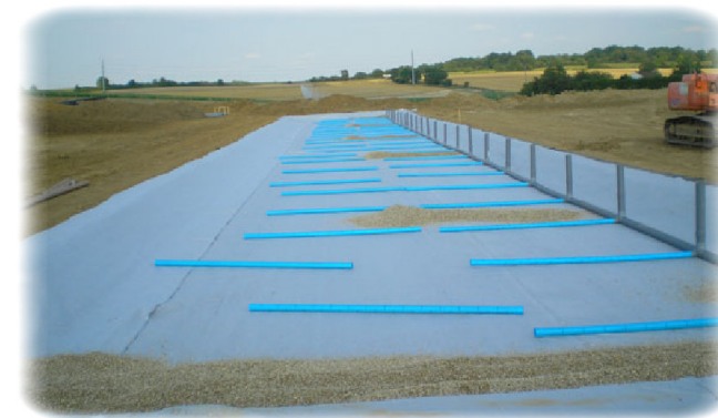
Pose de la géomembrane et des drains
