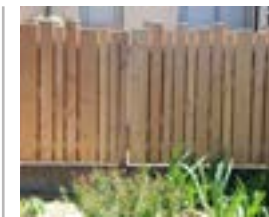
Palissade en bois
