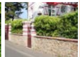
Muret, grille et haie
